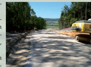
Neubau einer Bundesstraße
