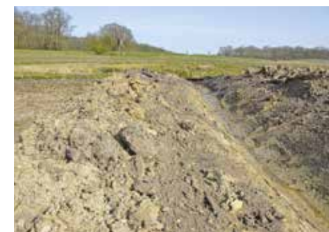
Zum Verlegen der Rohrleitung wurde ein Graben angelegt.
