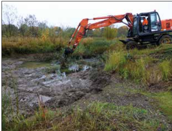
Bei starker Verlandung muss das Gewässer mit dem Bagger entschlammt werden
